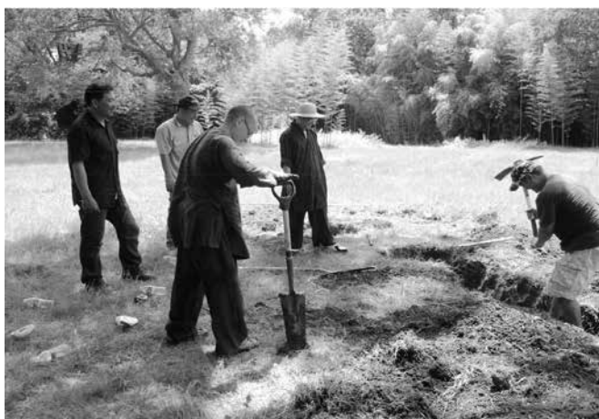
Đào tìm vị trí septic tank và thay đường ống xả bị rễ cây làm nghẹt
